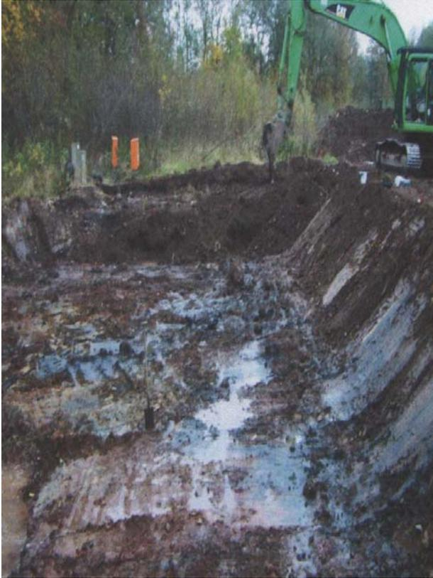
*Abb. Bodenaushub bis wassergesättigte Bodenzone*
