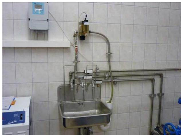
Hochbehälter Plaue – automatische Messung und Probenahmehähne
