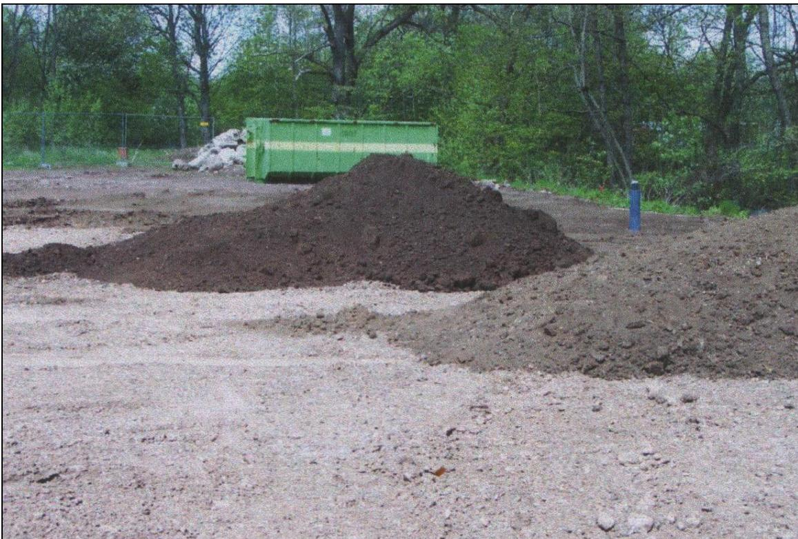
*Abb. verdichteter Verfüllboden und Aufbau des Oberbodens mit kulturfähigem Material*
