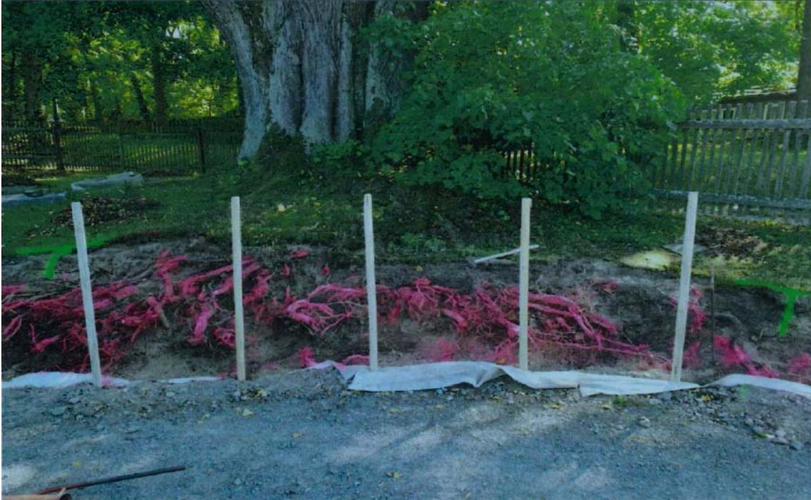
Abbildung 3: Durch die Errichtung der Baustraße beschädigte Wurzeln (rot);
