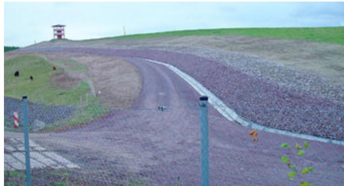
Die Baumaßnahmen auf der sanierten und rekultivierten Kreisabfalldeponie Wolfsberg sind abgeschlossen. Die Entwässerungsrinne an der Berme der Nord-Böschung wurde ausgetauscht und in diesem Zusammenhang der Weg zum Turm erneuert.
