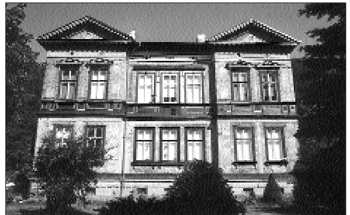
Gräfenroda, Am Bahnhof 5 Fotos: E. Huber
