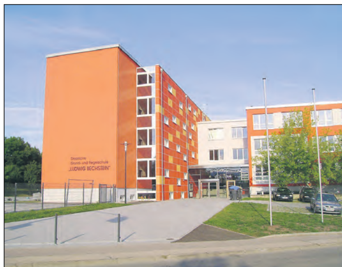
Nachdem im letzten Jahr bereits die Grundschule ihre neuen Räume beziehen konnte, können nun auch ab September die Schüler der Regelschule „Ludwig Bechstein“ in Arnstadt wieder in ihren ursprünglichen, nun aber komplett sanierten, Räumen lernen.
