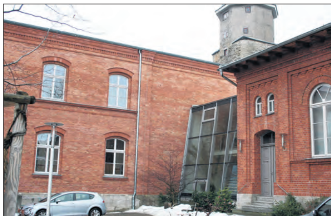
Das neue Gebäude des Stadt- und Kreisarchivs Arnstadt
